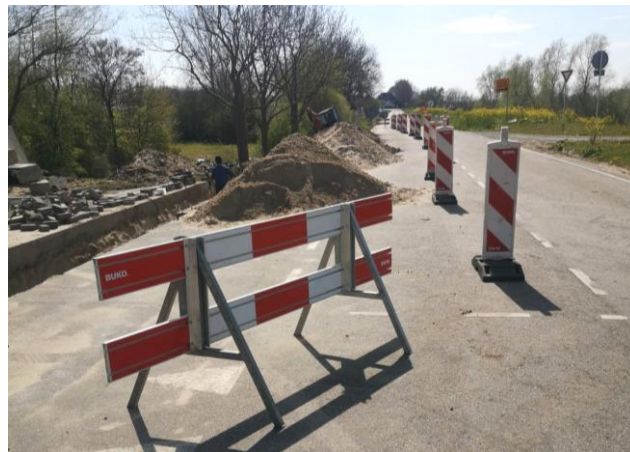
Foto: wegafzetting voor werkzaamheden in de sleuf
